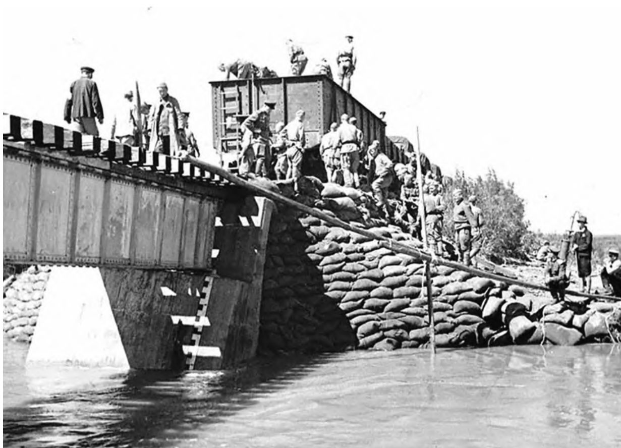
Восстановление железнодорожного моста, разрушенного японцами при отступлении. Маньчжурия.
